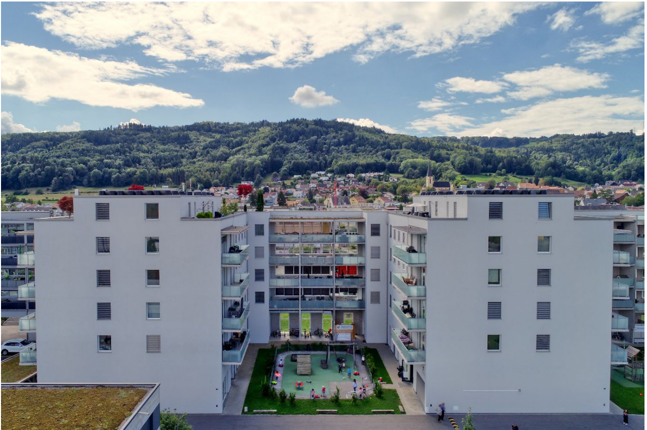
Willestrasse 5+7, Spreitenbach (AG)
